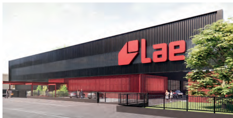
LAE Electronic. Nuova facciata dello stabilimento di Oderzo in corso di ristrutturazione
